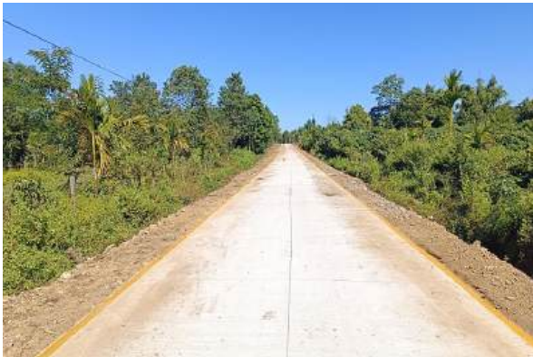
ကချင်ပြည်နယ်၊ ဝိုင်းမော်မြို့နယ်၊ နောင်ချိန်းကျေးရွာတွင်းလမ်း ကွန်ကရစ်ခင်းခြင်း
