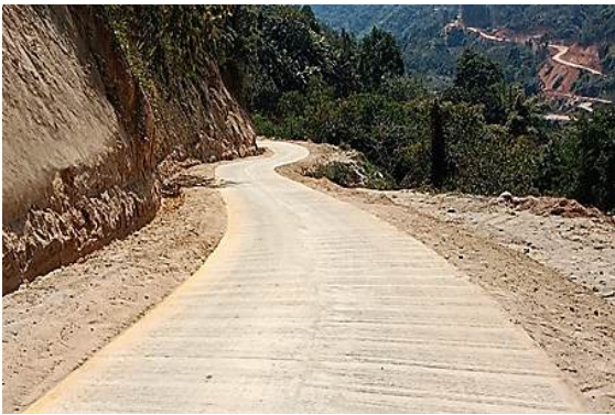
ကချင်ပြည်နယ်၊ ချီဖွေမြို့နယ်၊ ချီဖွေ-ဆော့လော် ၅၂/၀ မိုင် အနက် ၄-မိုင် တပ်စခန်းမှ စုစည်း- တောင်သုံးလုံး- မက်လင်ကော့လမ်း ၁၉/၀မိုင်အနက် ၁/၀ မိုင် ကွန်ကရစ်ခင်းခြင်း
