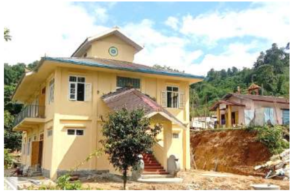
ကချင်ပြည်နယ်၊ ချီဖွေမြို့ပေါ်ရှိတောင်တန်း သာသနာပြု (ဗဟိုကျောင်း) ကျောင်းဆောင် RC ၂ ထပ် တည်ဆောက်ခြင်း
