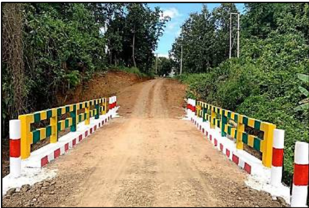
ကယားပြည်နယ်၊ လွိုင်ကော်မြို့နယ်၊ ပိန်းချစ်-ဝမ်ကုန်း ရွာချင်ဆက်လမ်း ပေါ်တွင် ၂၅ ပေ ကွန်ကရစ်တံတား ၁ စင်း တည်ဆောက်ခြင်း
