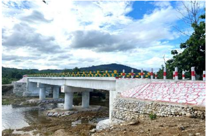
ကချင်ပြည်နယ်၊ ဝိုင်းမော်မြို့နယ်၊ လဝါးယန် ကျေးရွာ၊ အင်ဖုခ ချောင်းကူး ၁၂၅ ပေ ကွန်ကရစ်တံတား ၁ စင်း တည်ဆောက်ခြင်း
