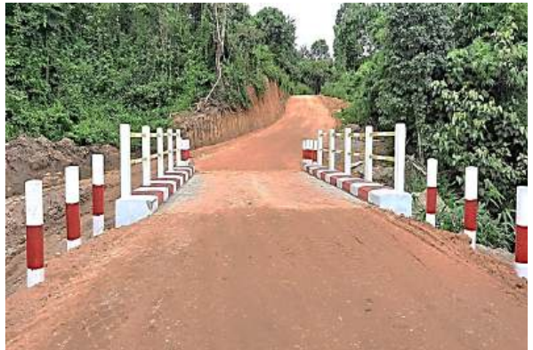
ရှမ်းပြည်နယ်(အရှေ့ပိုင်း)၊ မိုင်းဆတ်မြို့နယ်၊ ကျတီ-နားမ(၁) လမ်းပေါ်တွင် ၂၀' ကွန်ကရစ် တံတား ၁ စင်း တည်ဆောက်ခြင်း
