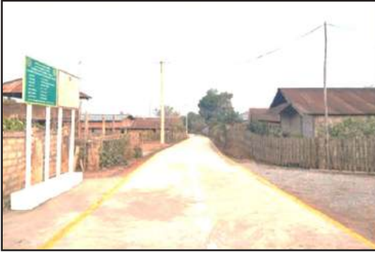
ရှမ်းပြည်နယ်(မြောက်ပိုင်း)၊ တန့်ယန်းမြို့နယ်၊ မန်ကောင်းကျေးရွာ၊ ကွန်ကရစ်လမ်းခင်းခြင်း
